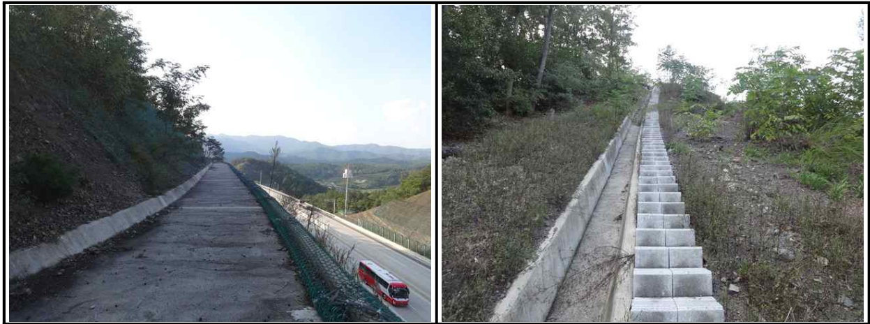
【그림 53.3.3】 배수시설 전경
